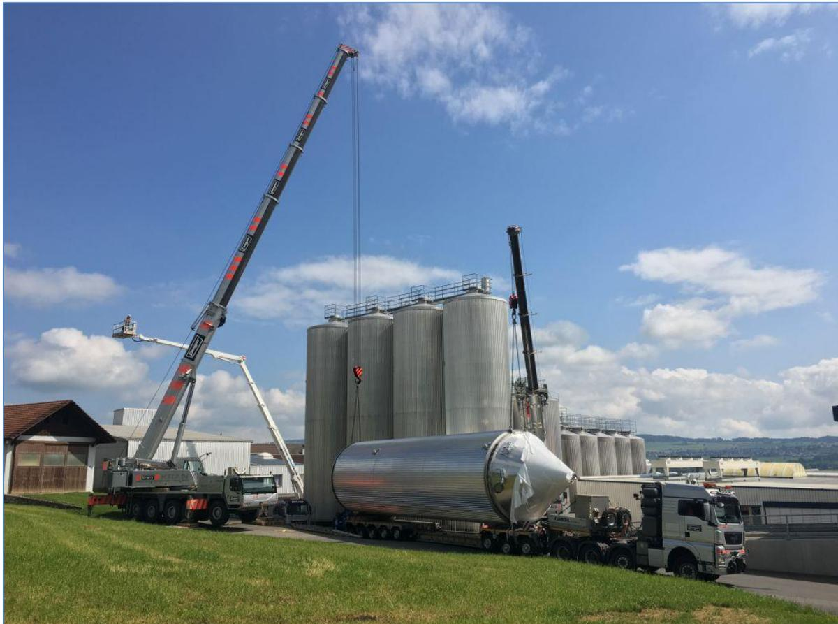
Der neue Gärtank in Hochdorf. Dieser fasst bei einem Durchmesser von 4.76 Metern und einer Höhe von 19.64 Metern ein Volumen von 250'000 Litern. Das Tankgewicht beträgt 17 Tonnen (Tara). Der Tank ist isoliert und kann gekühlt werden. (Bildquelle: RAMSEIER Suisse AG)
