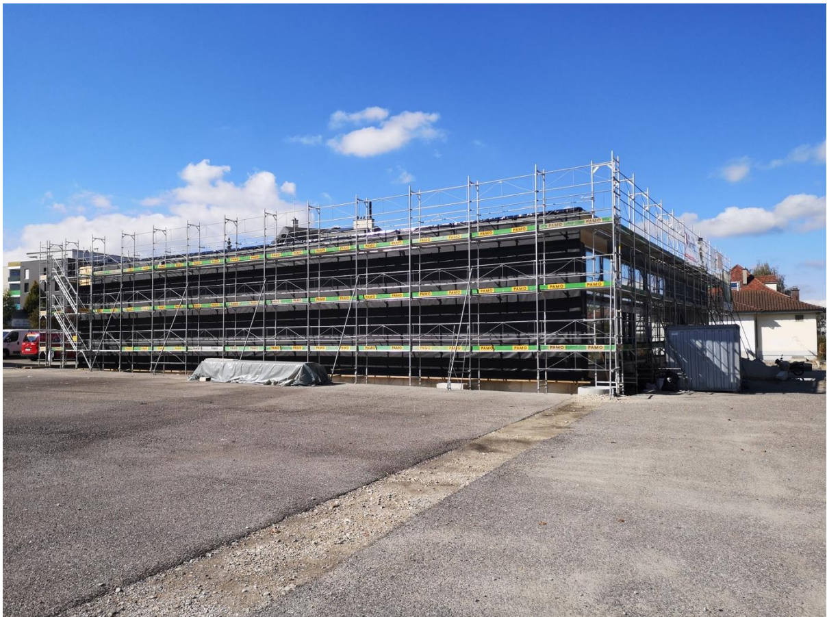
Der Rohbau der Erlebniswelt der RAMSEIER Suisse AG
